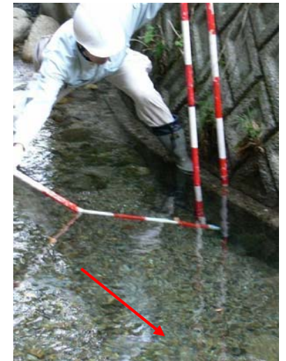
護岸基礎部の洗掘状:
